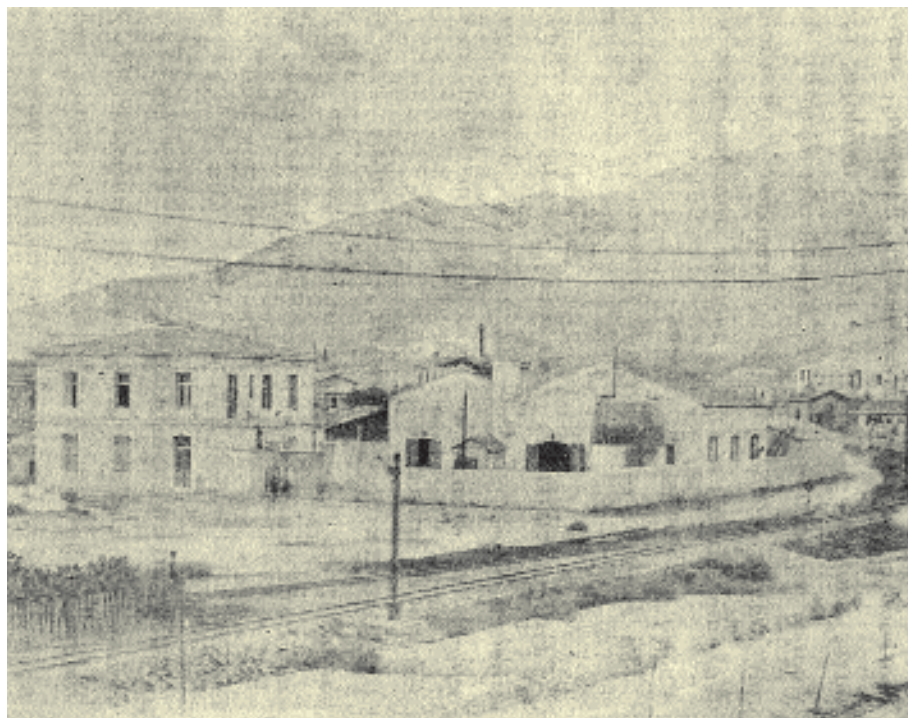
Εικ. 3: Το ηλεκτρικό εργοστάσιο Καλαμών (Στράτος Κτεναβέας, Μεσσηνιακή Επετηρίς 1908 , σ. 175).
